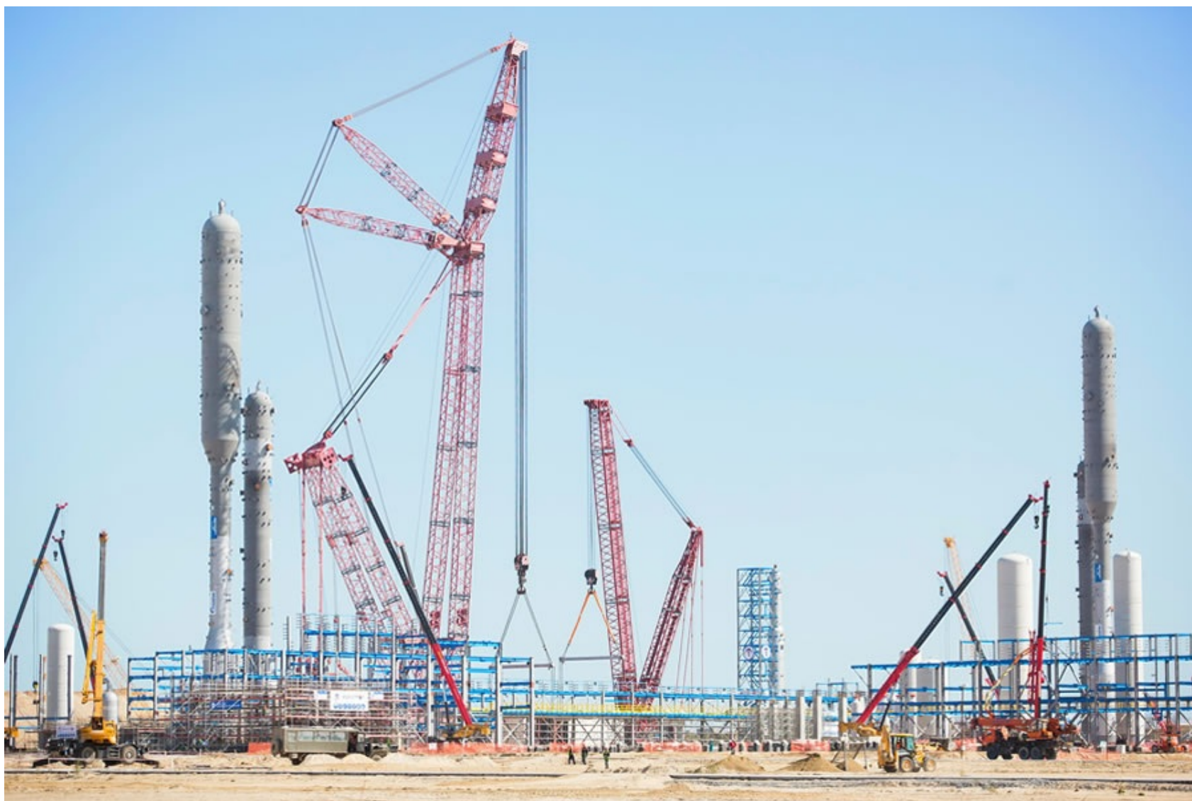
Строительная площадка Амурского газоперерабатывающего завода.
