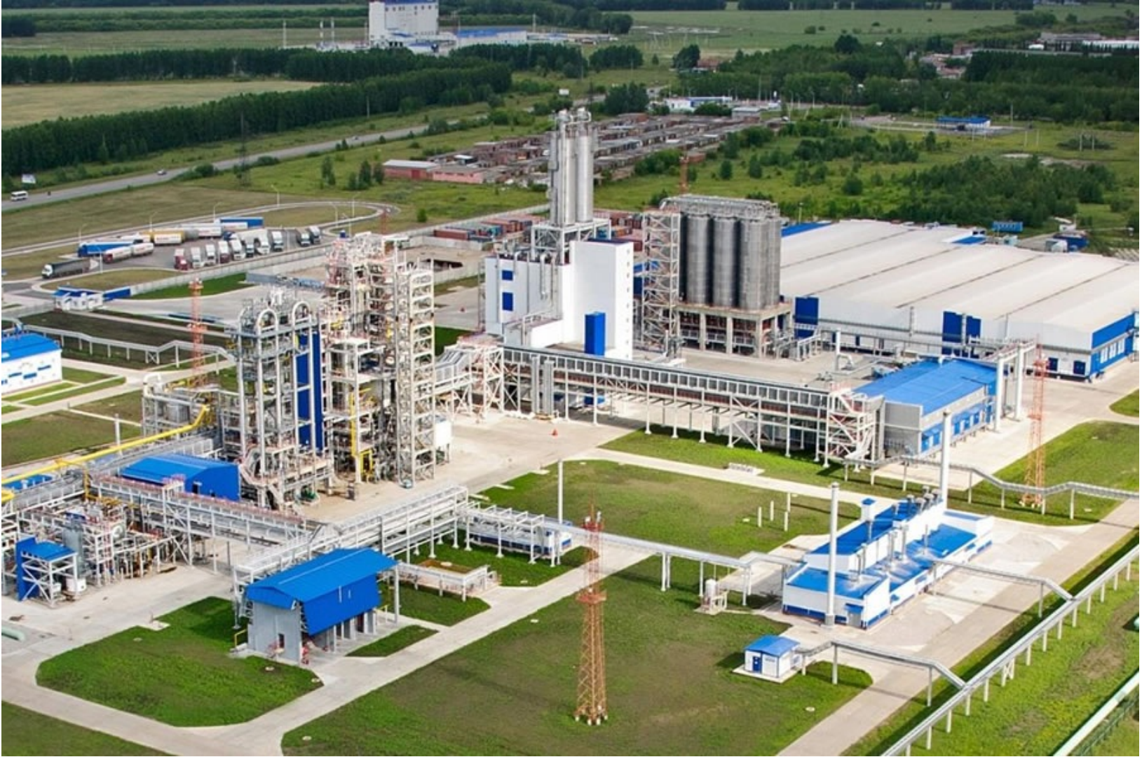
Производственная площадка ООО «Полиом». Фото: poliom-omsk.ru .
